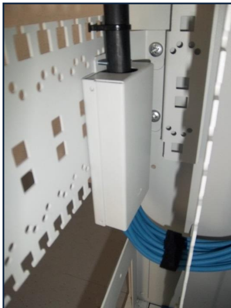
Illustration – Exemple d'équerre d'arrimage du boîtier éclateur
